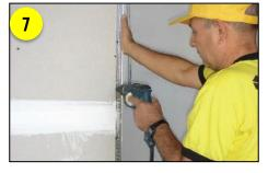
Según el nivel de masillado seleccionado para la pared (ver IT-Niveles da masillado y CS-Tomado de juntas ), se realiza el tomado de juntas con Masilla Durlock® y cinta de papel microperforada y el masillado de fijaciones y perfiles de terminación.
